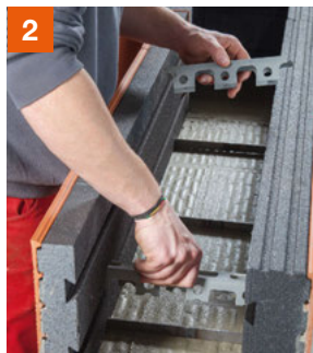
Bewehrungshalterung positionieren
