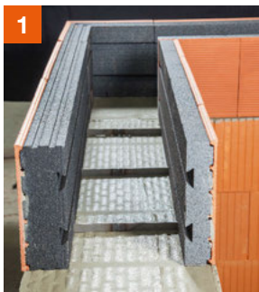
Dämmschale setzen
